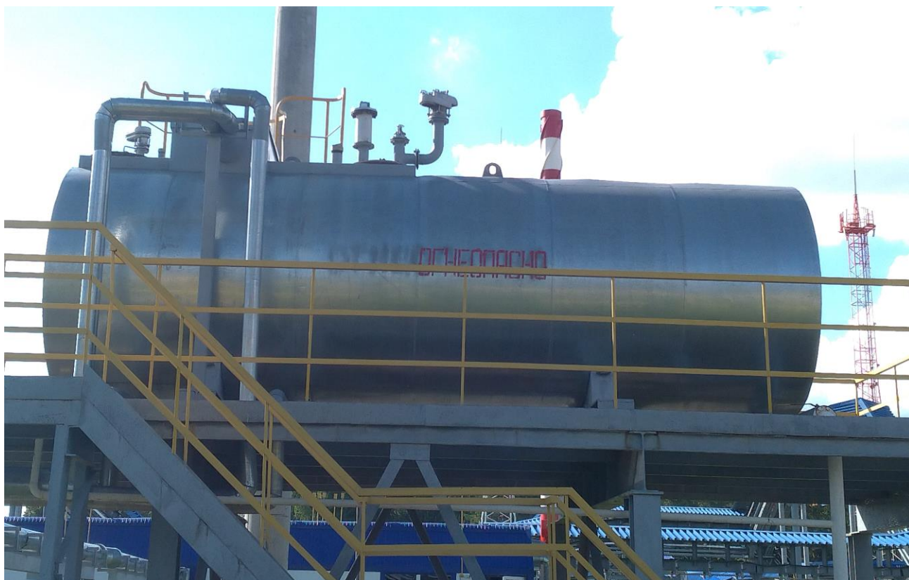
Рисунок 1 – Общий вид резервуара РГС-20
