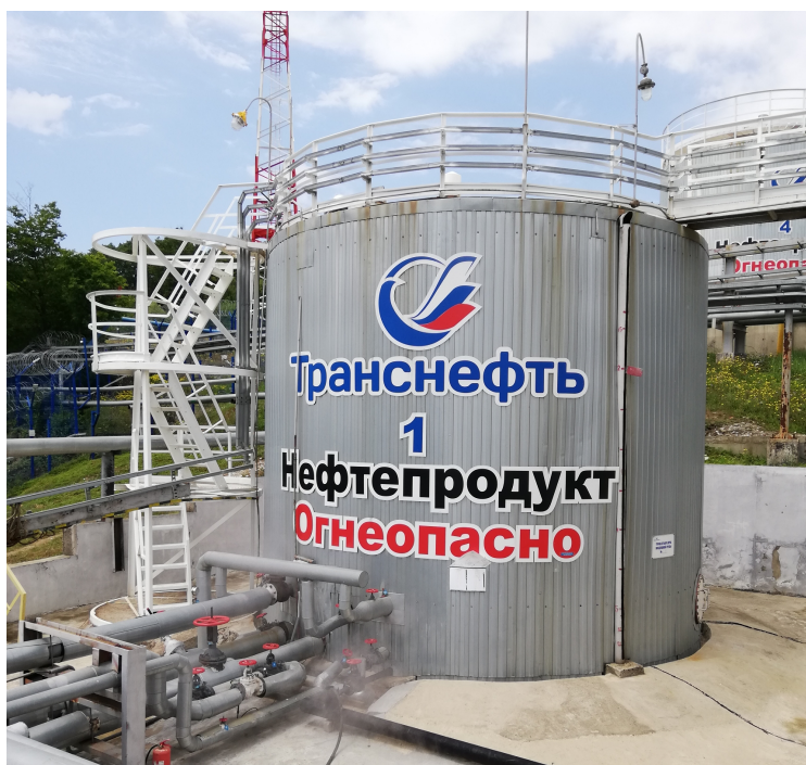
Рисунок 1 – Общий вид резервуаров стальных вертикальных цилиндрических РВС-200
