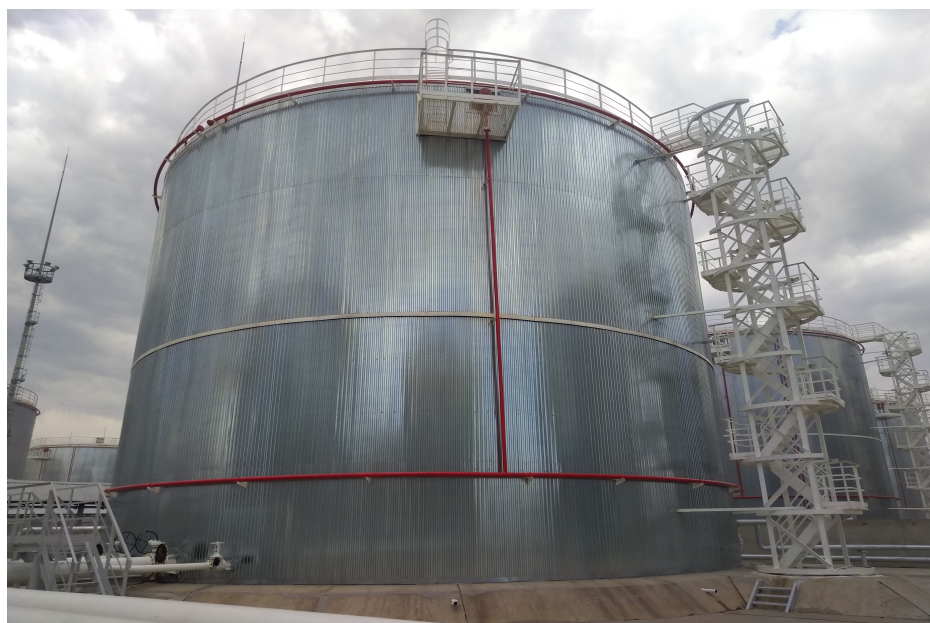
Рисунок 1 – Общий вид резервуара РВСт-5000
