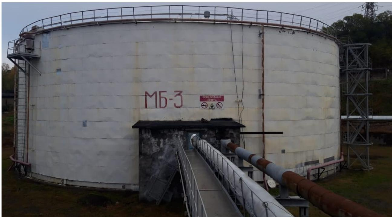
Рисунок 1 – Общий вид резервуара РВС-10000
