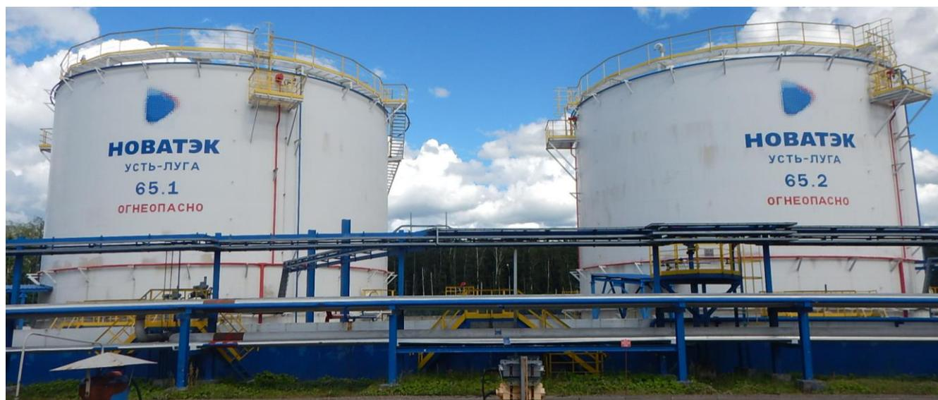
Рисунок 1 – Общий вид резервуаров стальных вертикальных цилиндрических РВСП-5000, заводские номера 65.1 и 65.2
