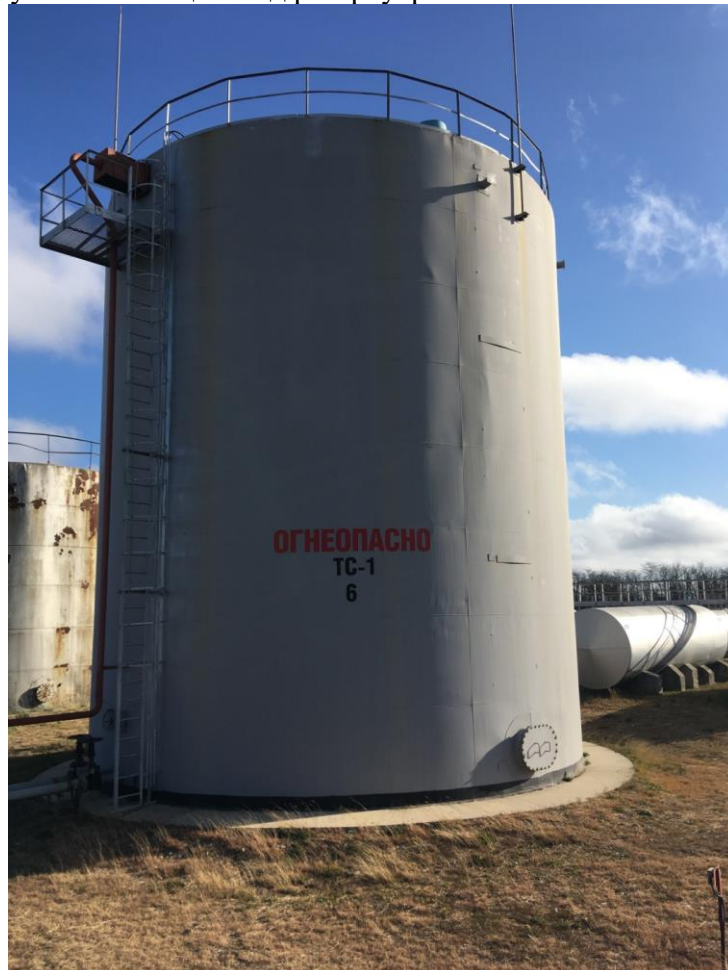
Рисунок 2 – Общий вид резервуара РВС-1000 зав.№ 6
