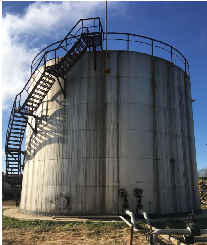
Рисунок 1 – Общий вид резервуаров РВС-1000 зав. №№ 4, 5
