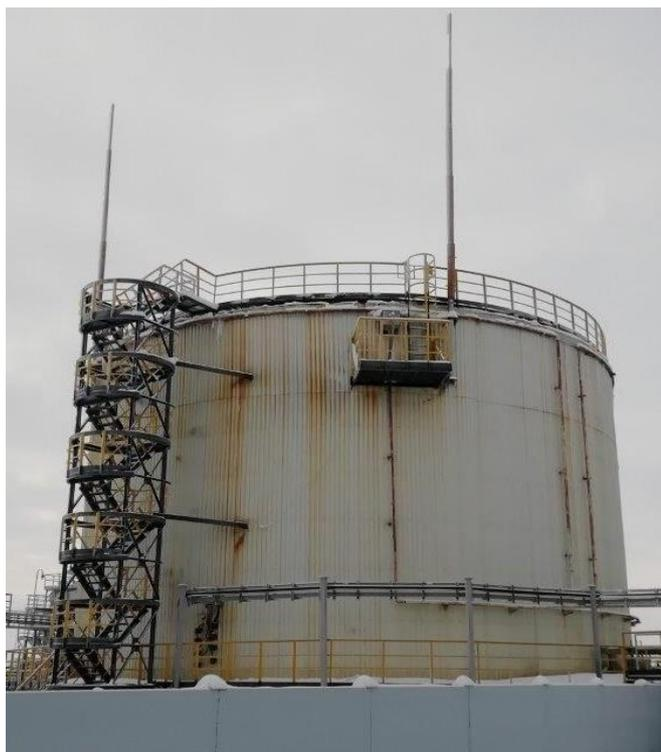
Рисунок 1 – Общий вид резервуара стального вертикального цилиндрического теплоизолированного РВС-3000
