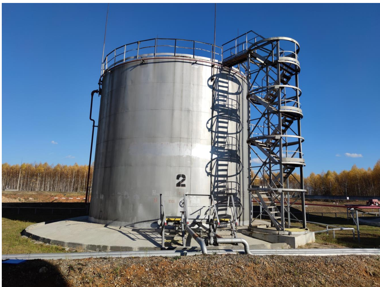
Рисунок 1 – Общий вид резервуара вертикального стального цилиндрического PVC-700
