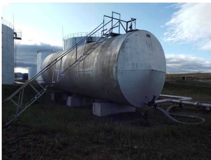
Рисунок 1 – Общий вид резервуара РГС – 75 зав.№111
