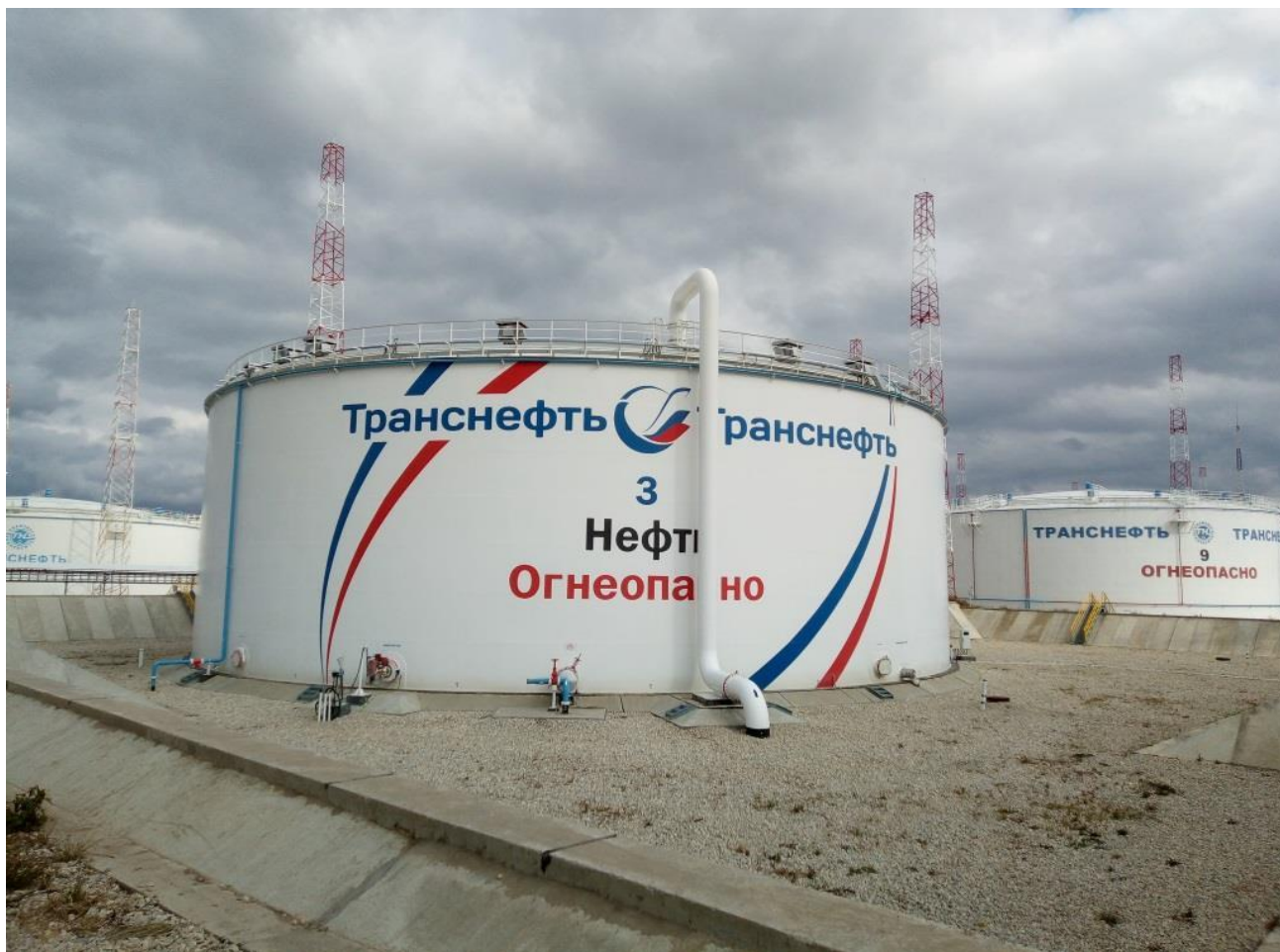
Рисунок 1 – Общий вид резервуара РВС-20000
