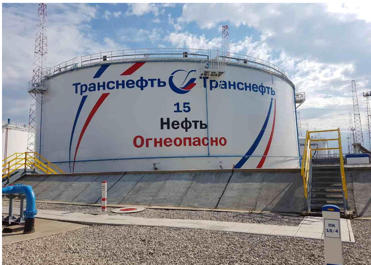
Рисунок 1 – Общий вид резервуара РВСП-20000
