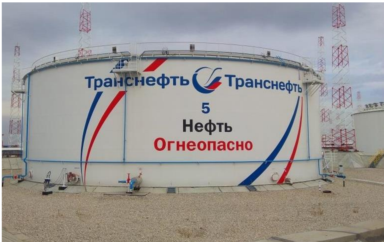
Рисунок 1 – Общий вид резервуаров РВСП-20000
