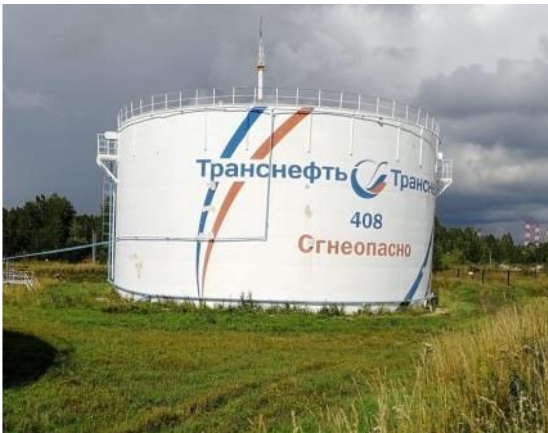
Рисунок 1 – Общий вид резервуаров РВСП-5000
