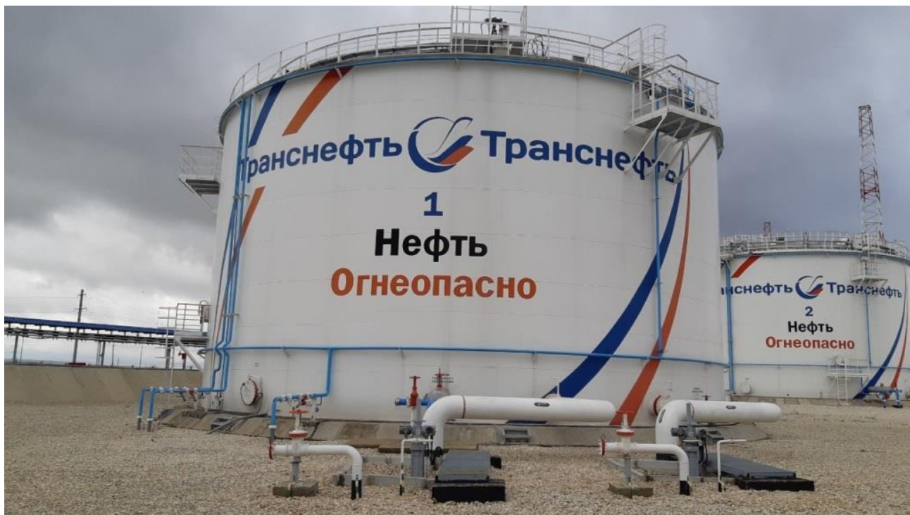
Рисунок 1 – Общий вид резервуаров РВСП-5000
