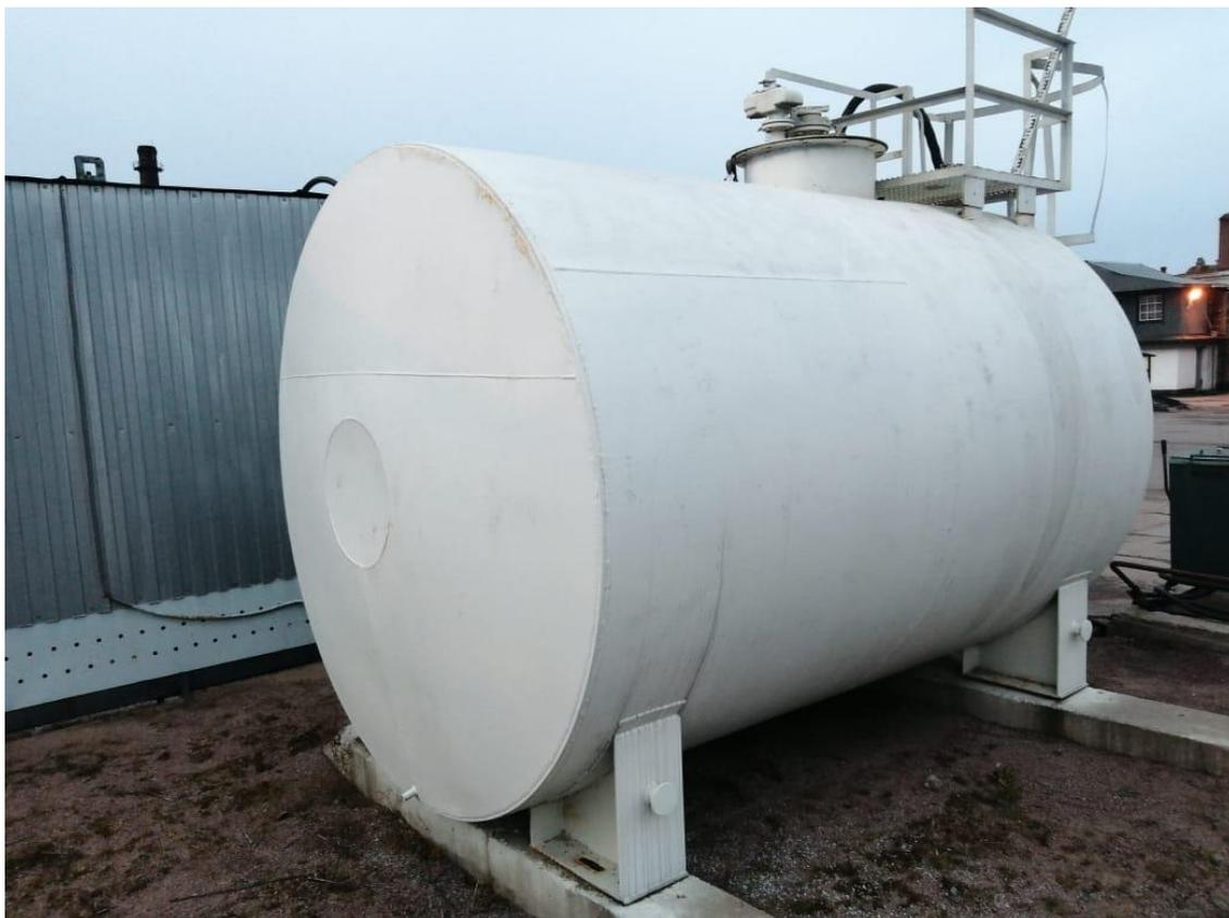
Рисунок 1 – Общий вид резервуаров РГС-10
