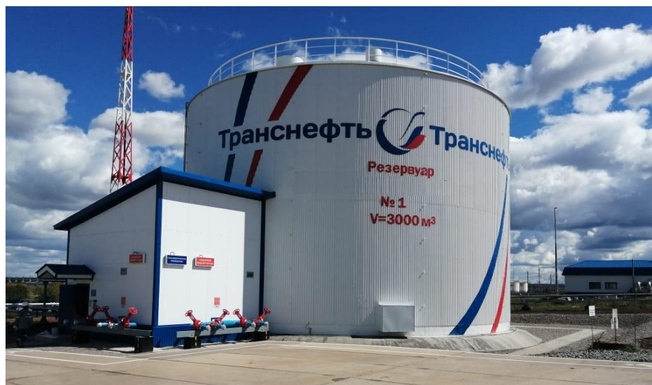
Рисунок 1 – Общий вид резервуара вертикального стального цилиндрического РВСт-3000
