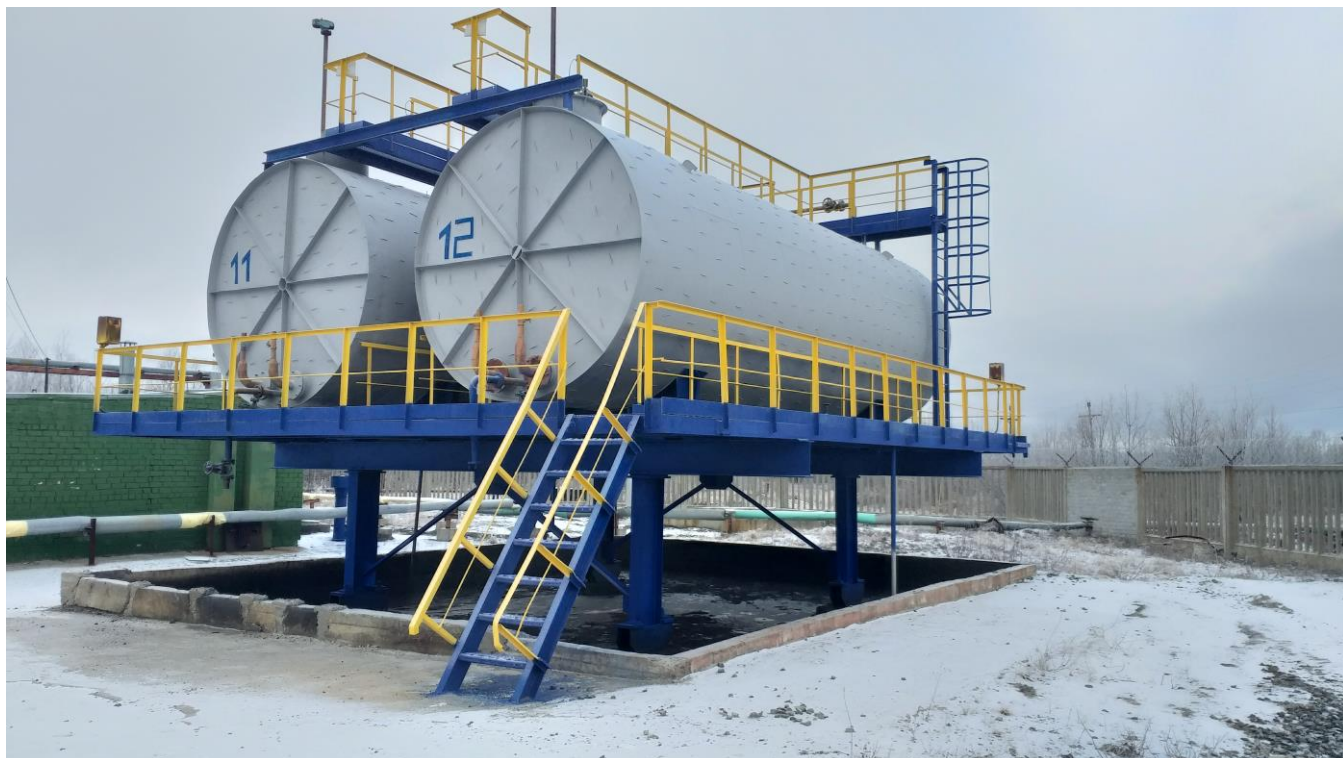
Рисунок 1 – Общий вид резервуаров РГС-75
