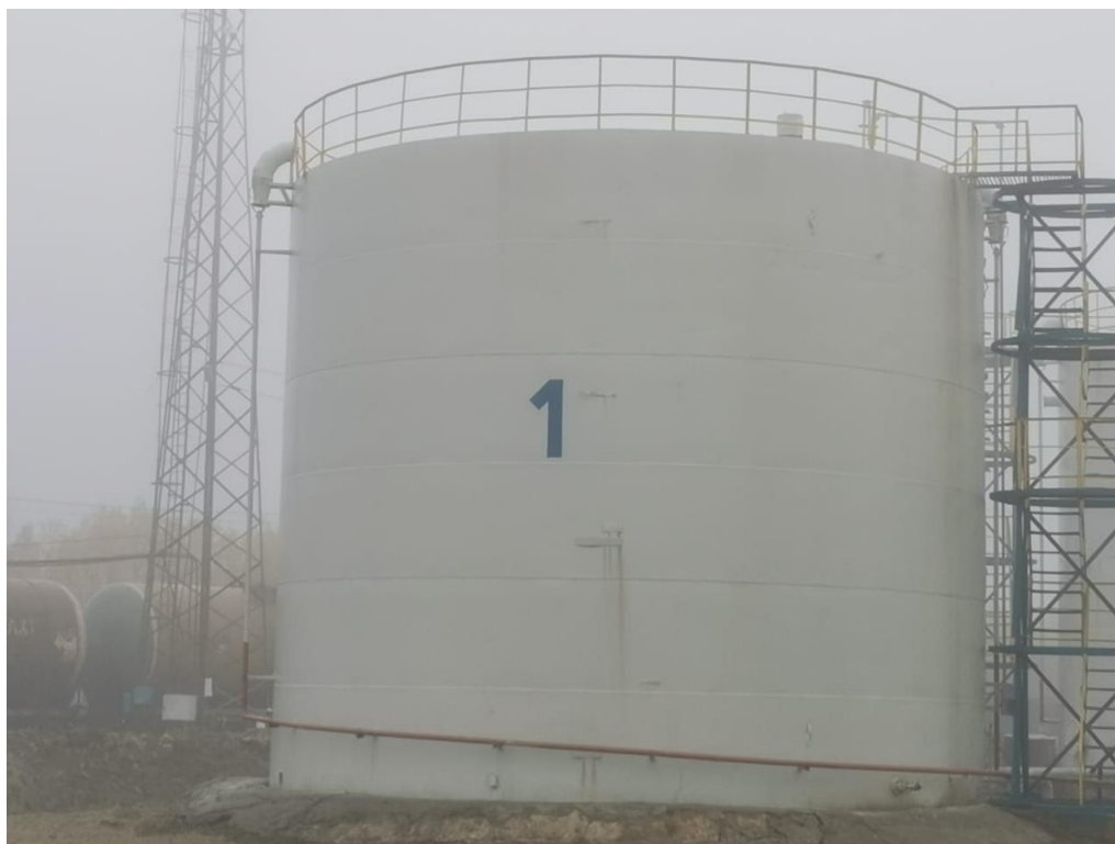
Рисунок 1 – Общий вид резервуара РВС-700
