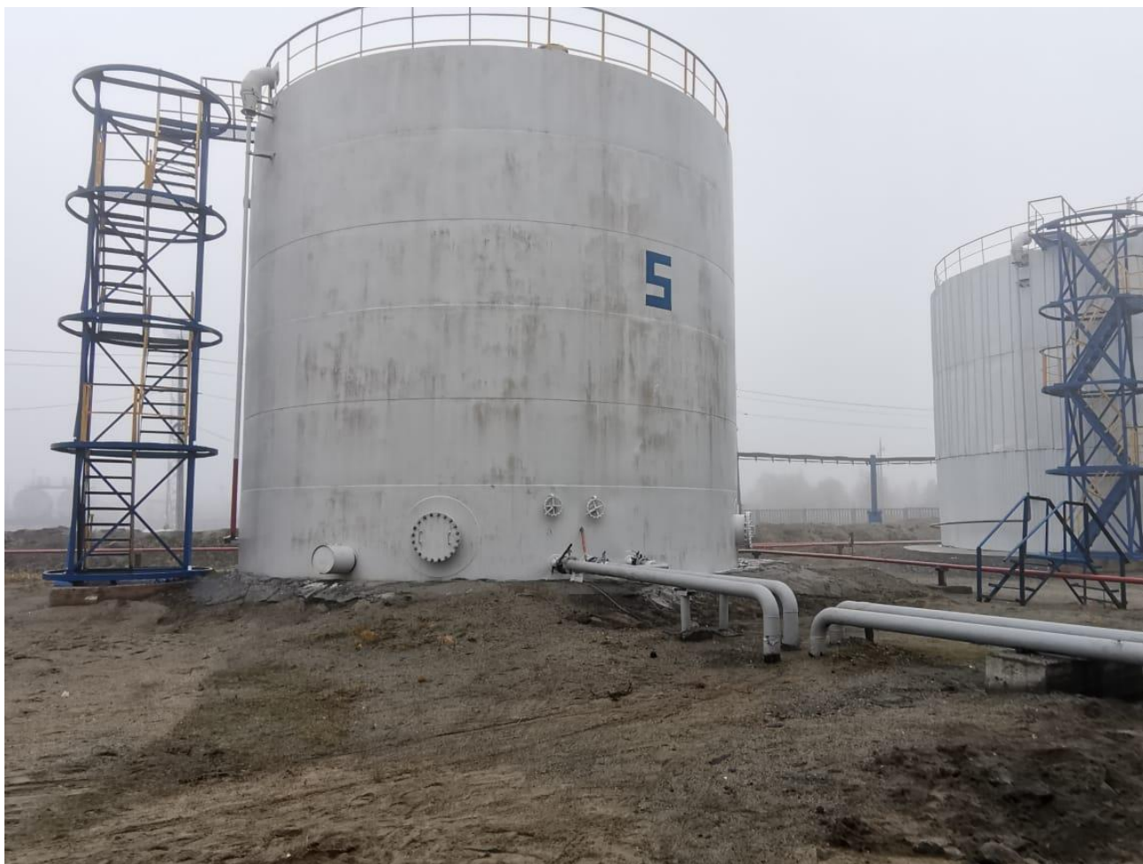
Рисунок 1 – Общий вид резервуаров РВС-700
