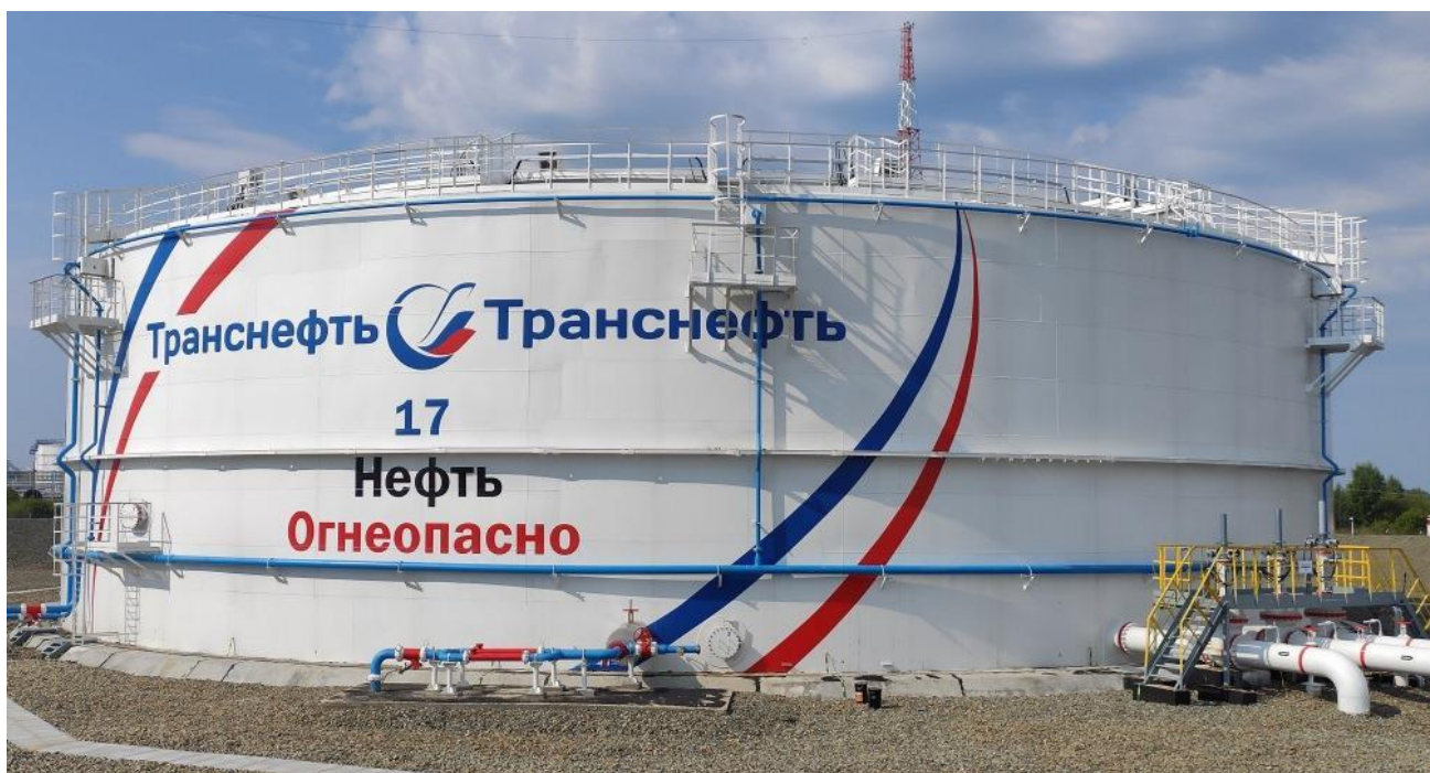
Рисунок 1 – Общий вид резервуаров РВСП-20000
