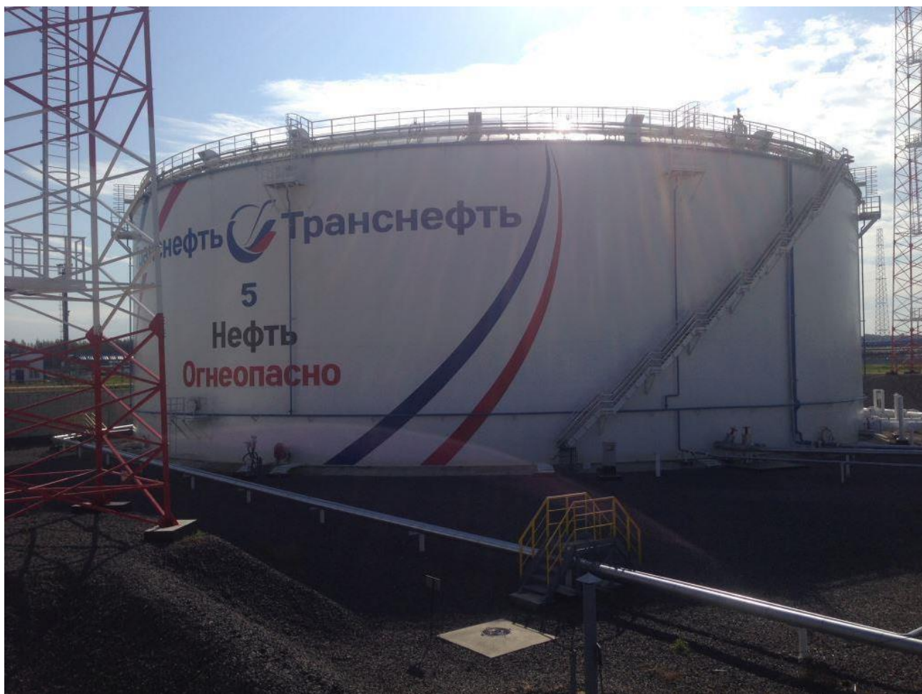
Рисунок 1 – Общий вид резервуара РВСП-50000
