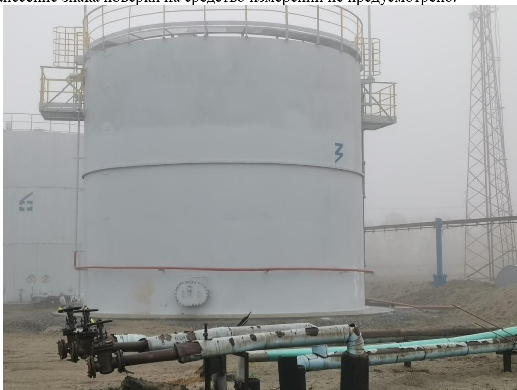
Рисунок 1 – Общий вид резервуара РВС-700
