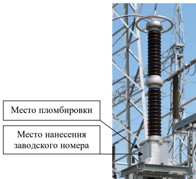
Рисунок 1 – Общий вид средства измерений с указанием места пломбировки, места нанесения заводского номера
