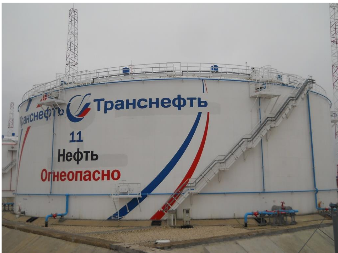
Рисунок 1 – Общий вид резервуара РВСП-20000
