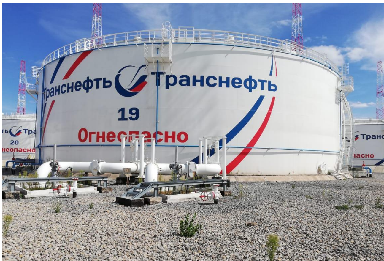
Рисунок 1 – Общий вид резервуаров РВСП-20000
