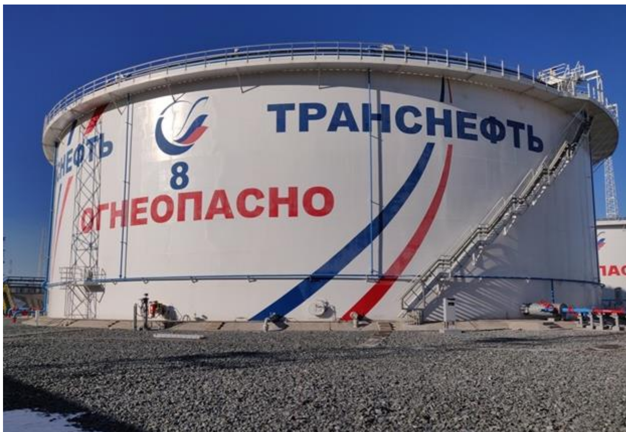
Рисунок 1 – Общий вид резервуаров РВСПК-50000
