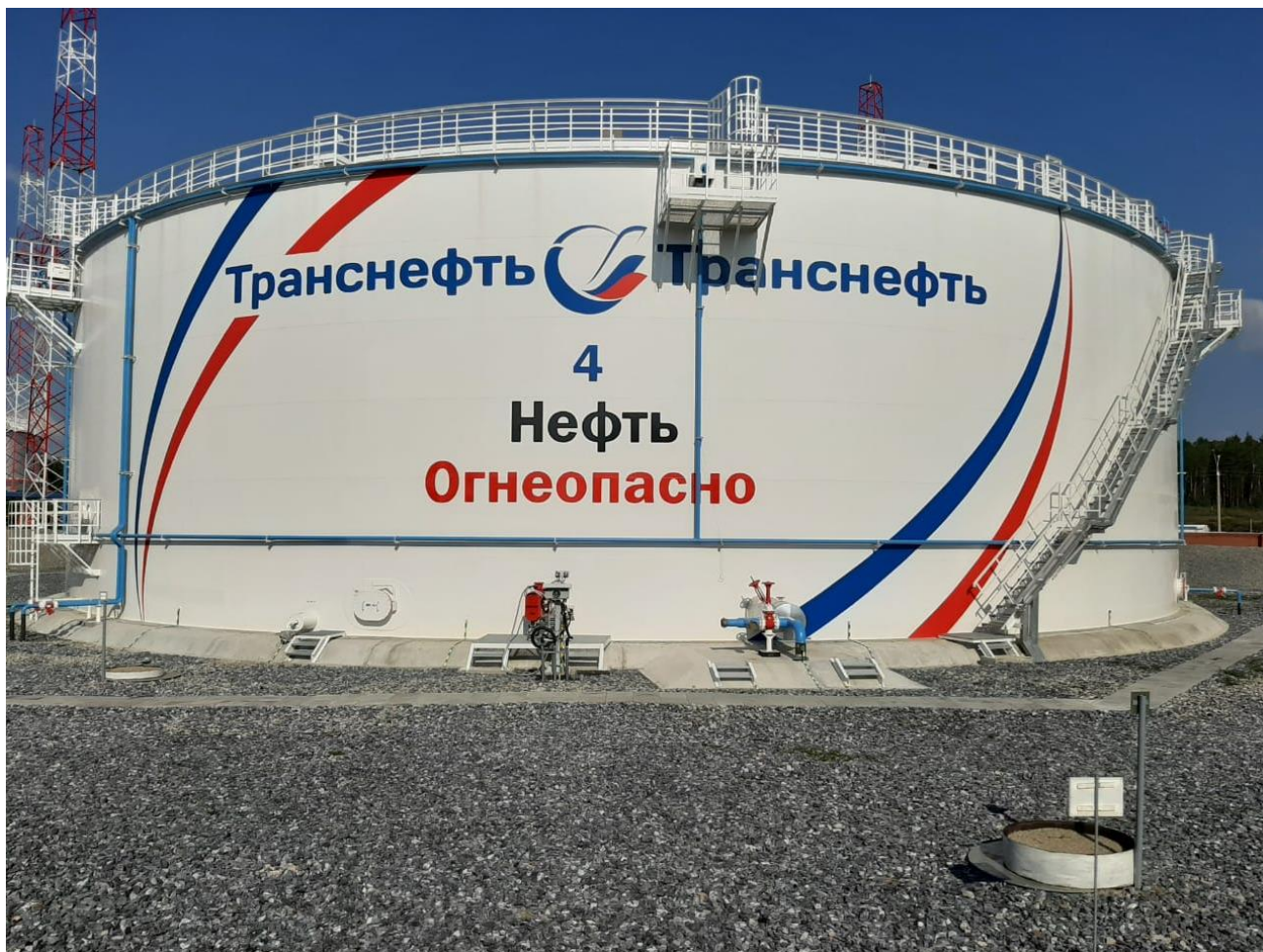
Рисунок 1 – Общий вид резервуара РВСП-20000
