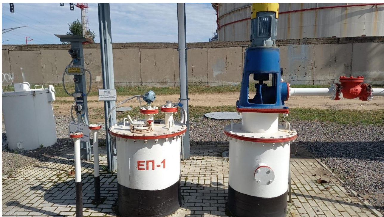
Рисунок 1 – Общий вид резервуара РГС-12,5
