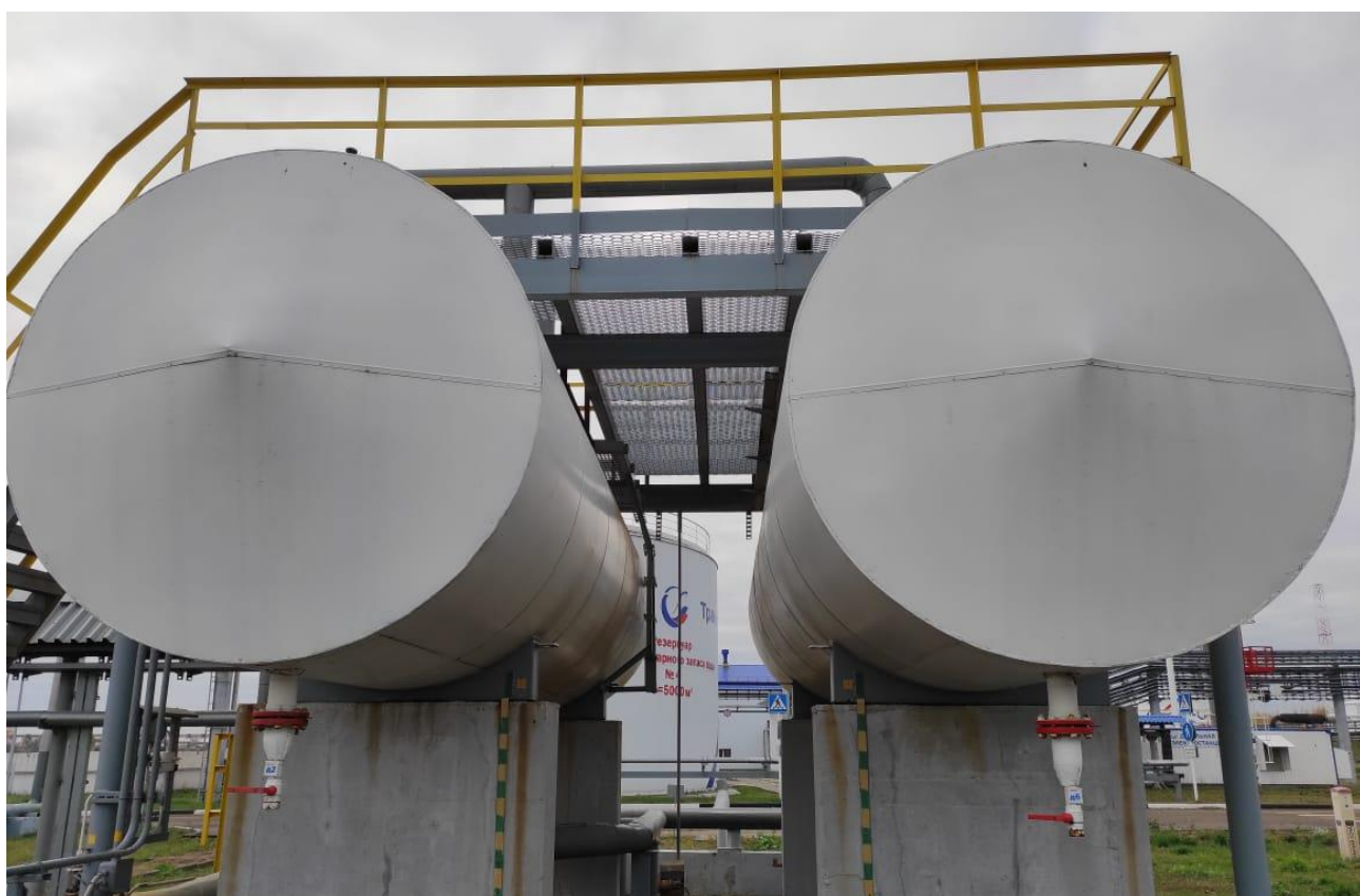
Рисунок 2 – Общий вид резервуаров РГС-20
