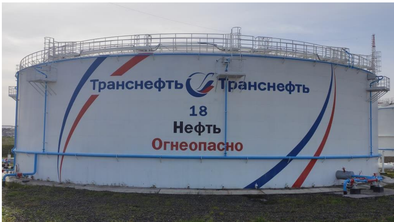
Рисунок 2 – Общий вид резервуара РВС-20000
