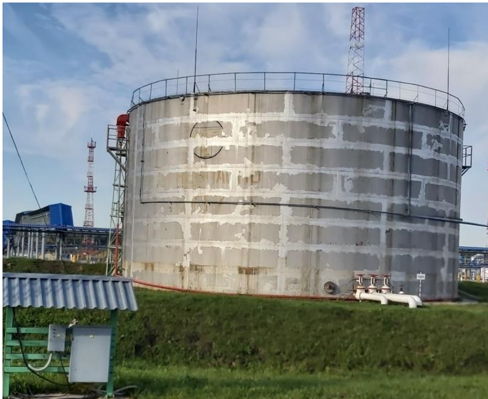
Рисунок 1 – Общий вид резервуаров РВС-5000
