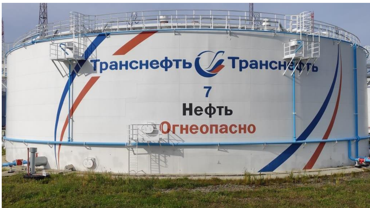
Рисунок 3 – Общий вид резервуара РВСП-20000
