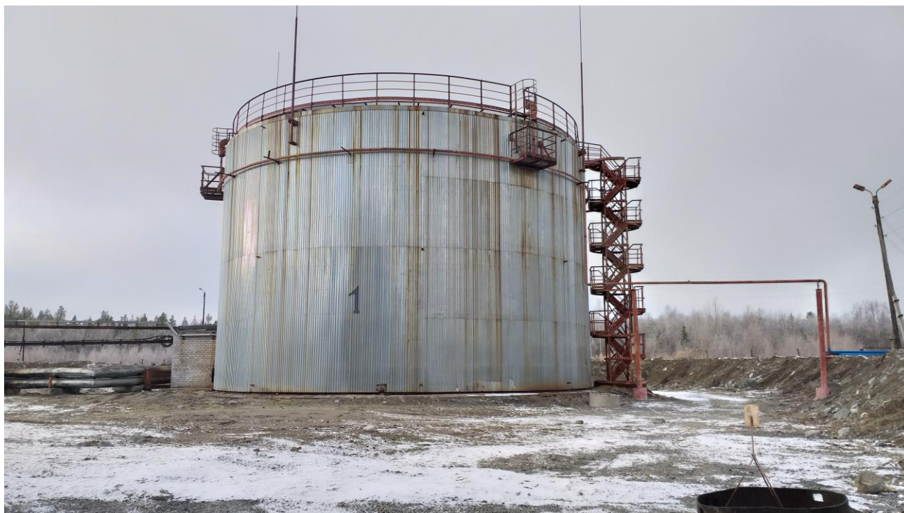
Рисунок 1 – Общий вид резервуара РВС-3000
