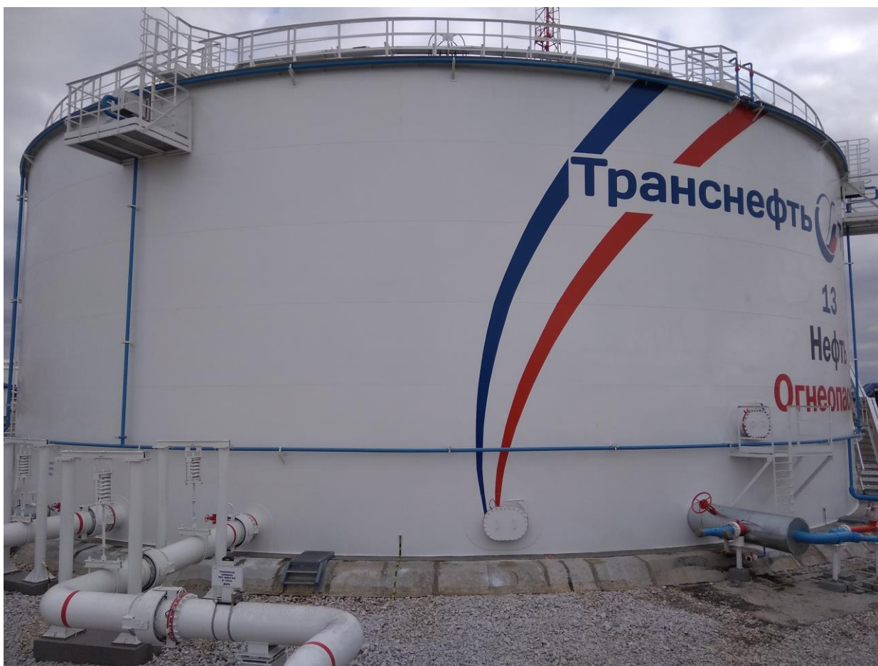
Рисунок 1 – Общий вид резервуаров стальных вертикальных цилиндрических РВСП-10000
