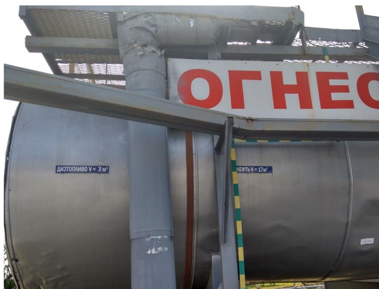
Рисунок 1 – Общий вид резервуаров
