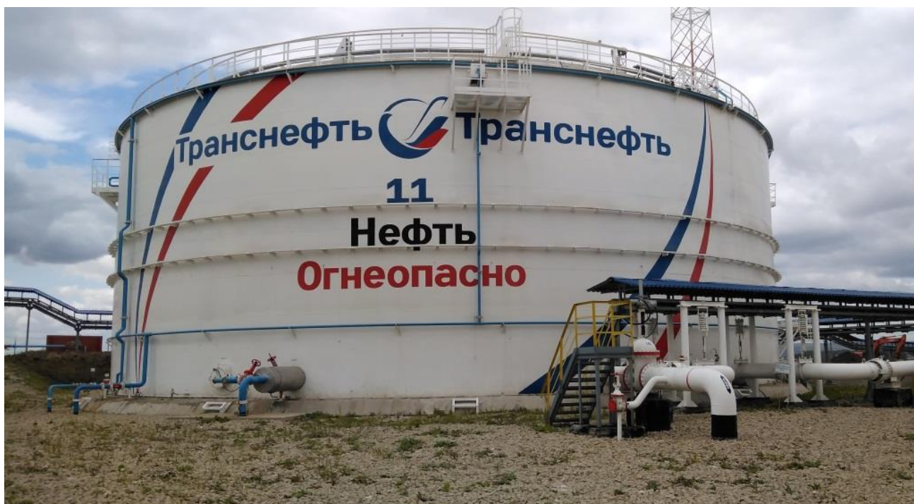
Рисунок 1 – Общий вид резервуара РВСП-10000
