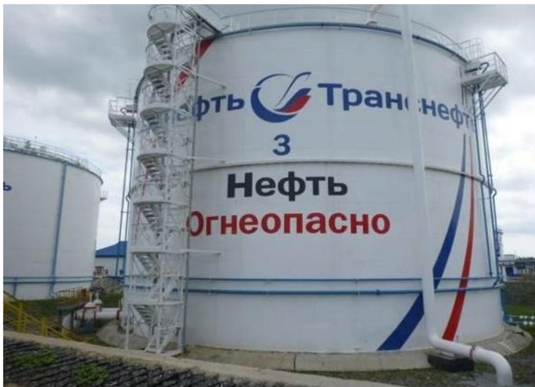
Рисунок 2 – Общий вид резервуара РВС-10000
