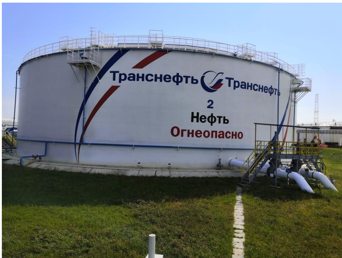
Рисунок 1 – Общий вид резервуара РВС-20000
