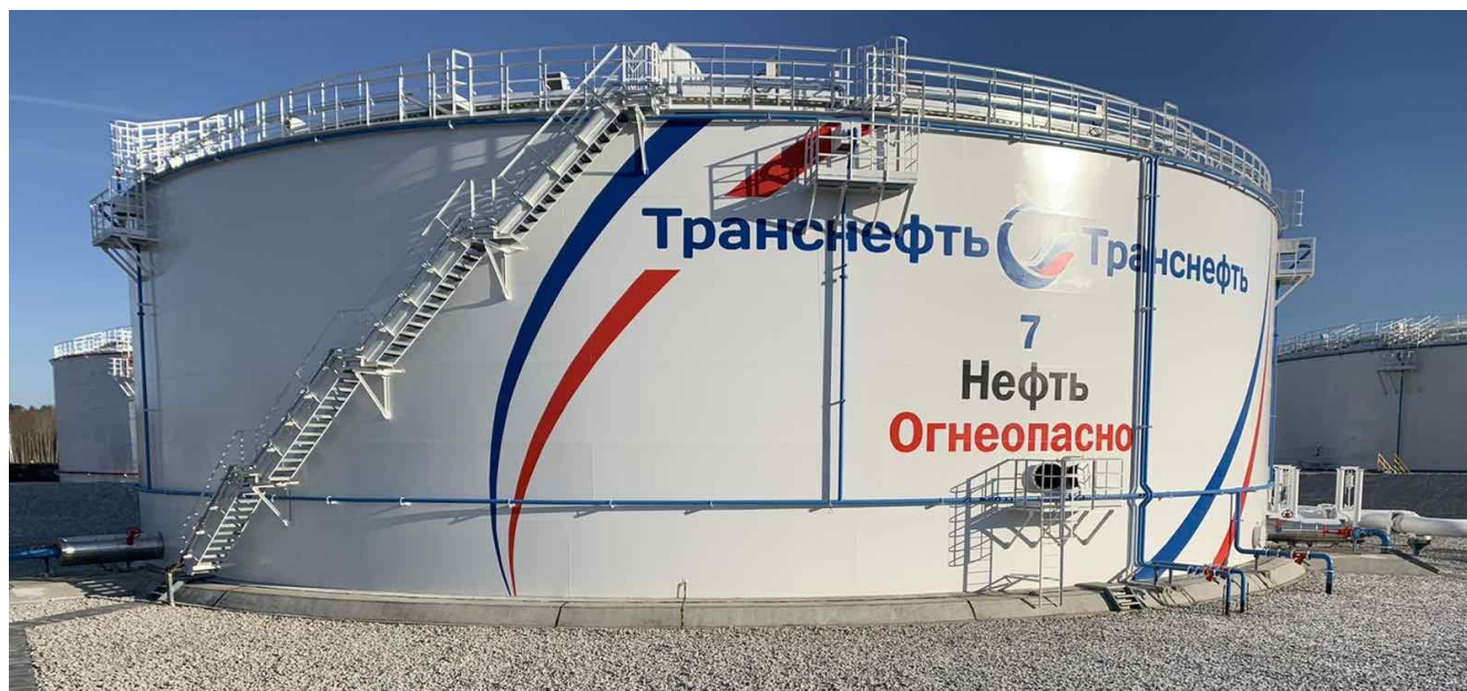
Рисунок 1 – Общий вид резервуара вертикального стального цилиндрического РВСП-20000, заводской номер 7
