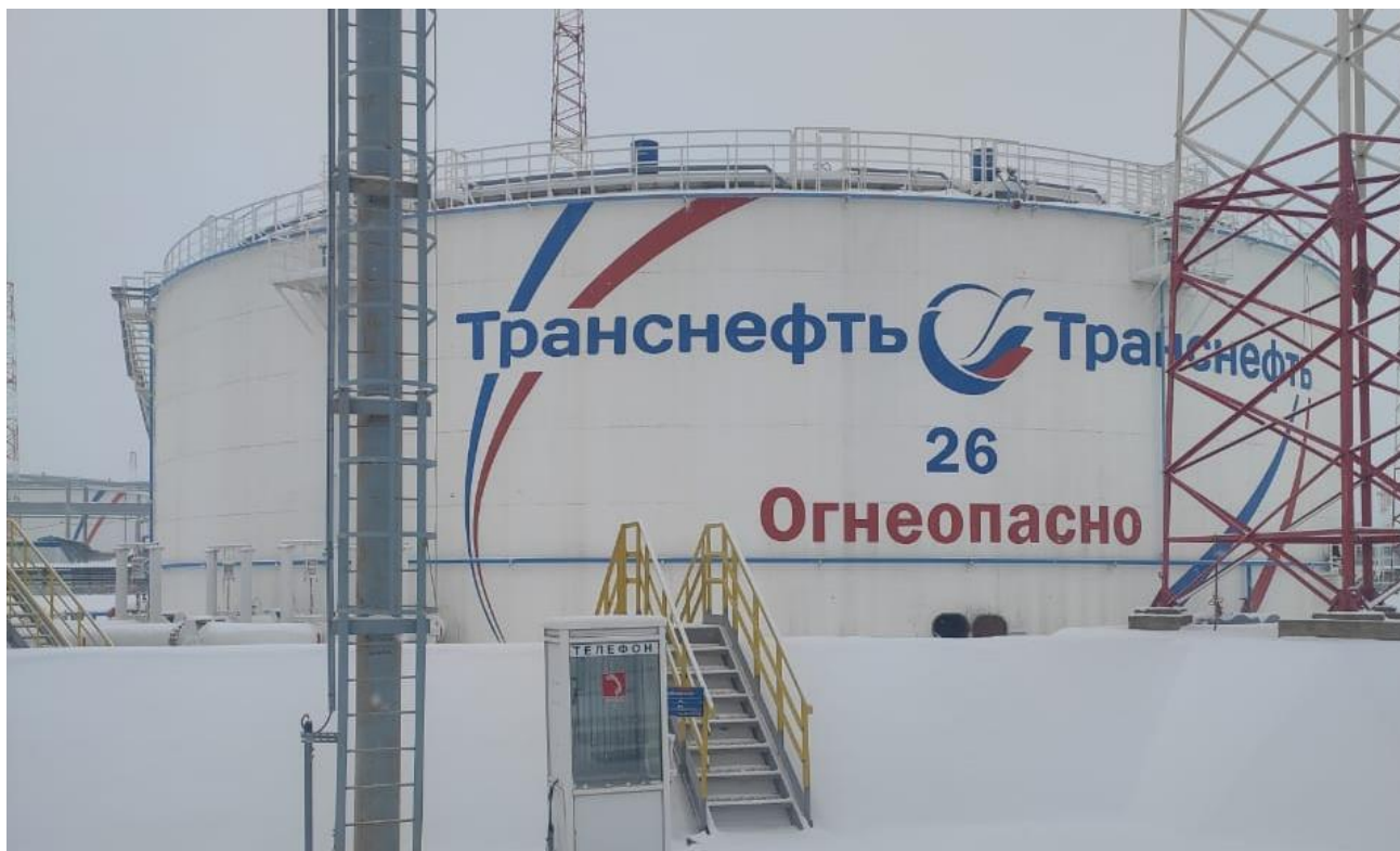
Рисунок 1 – Общий вид резервуара РВСП-20000
