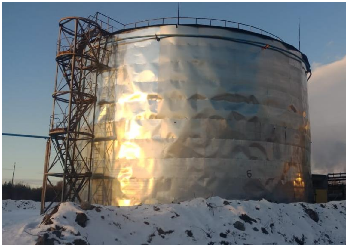
Рисунок 1 – Общий вид резервуара РВС-3000
