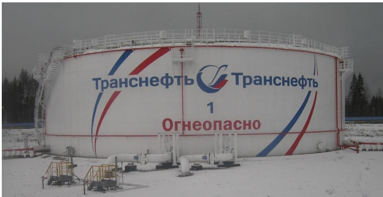
Рисунок 1 – Общий вид резервуара РВСП-20000
