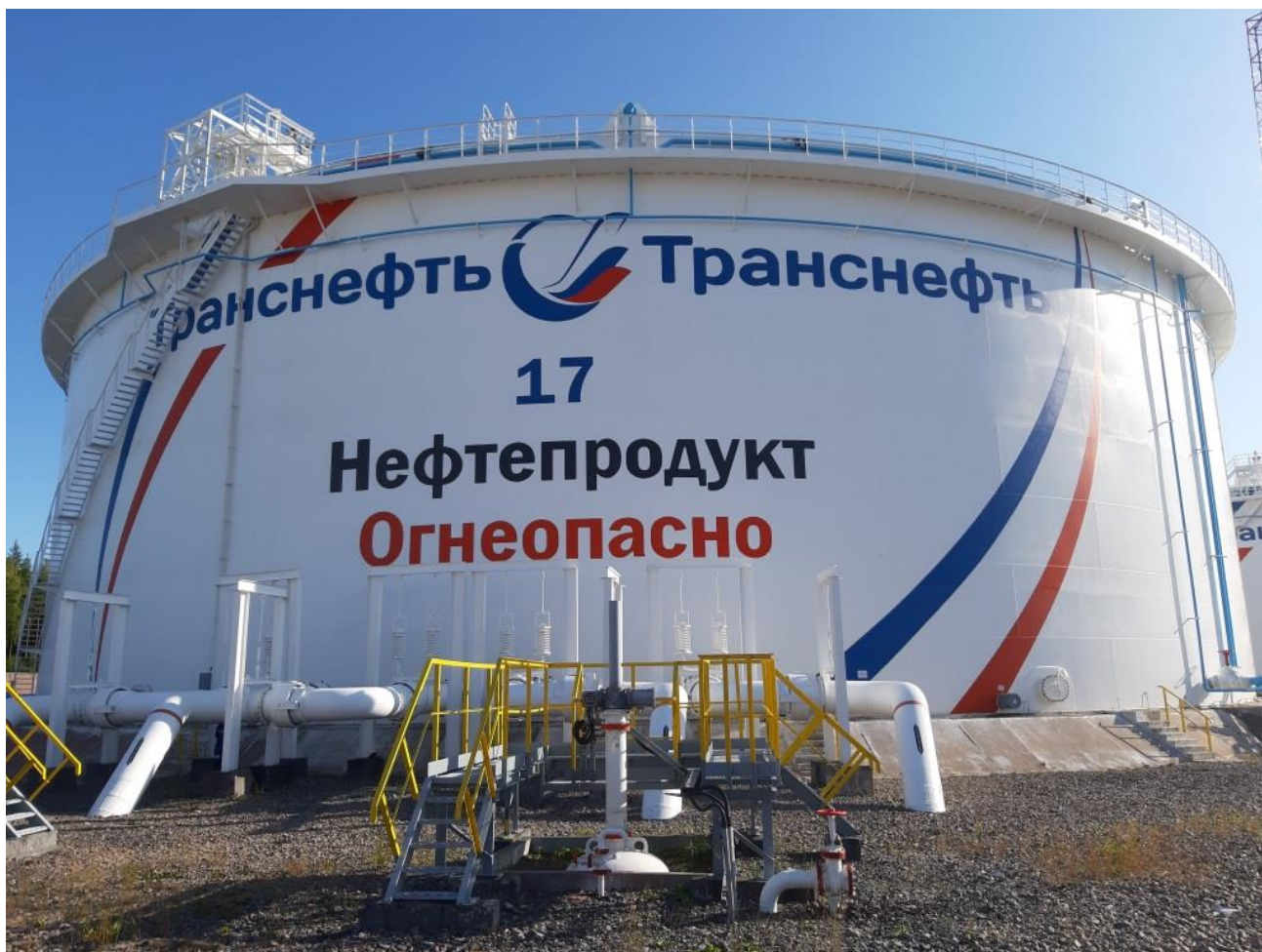
Рисунок 1 – Общий вид резервуара РВСПК-50000
