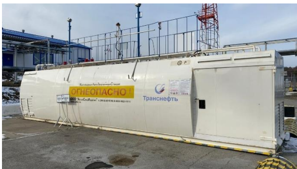
Рисунок 5 – Общий вид резервуара РГС-20
