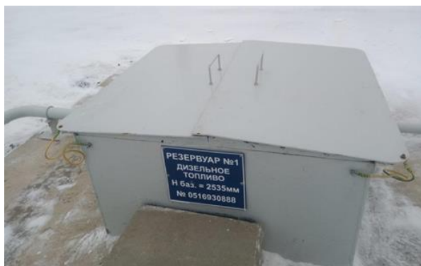
Рисунок 3 – Общий вид резервуаров РГС-10
