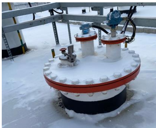
Рисунок 7 – Общий вид резервуара РГС-50
