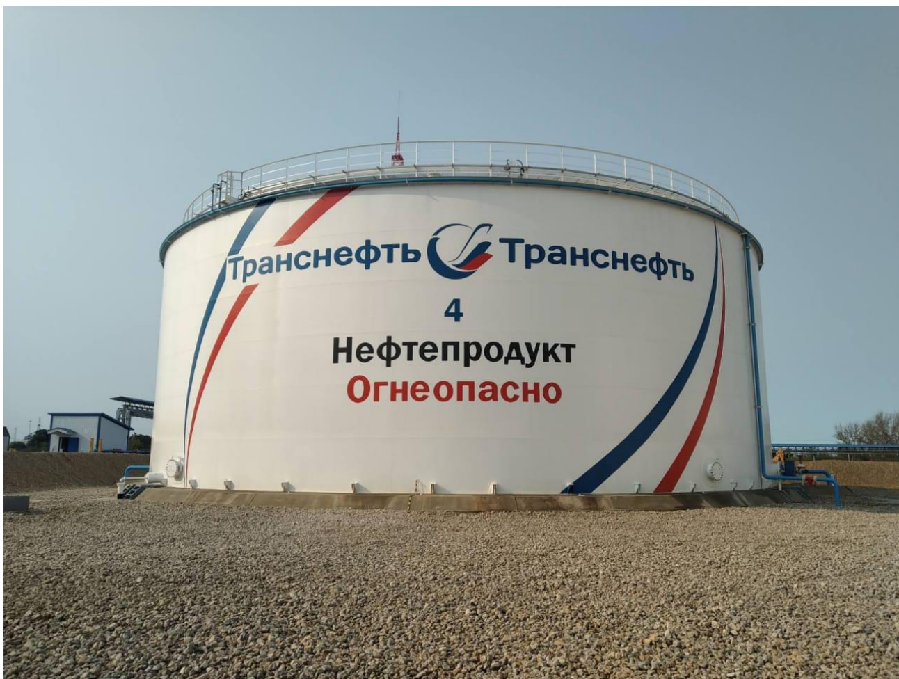
Рисунок 1 – Общий вид резервуара РВС-10000
