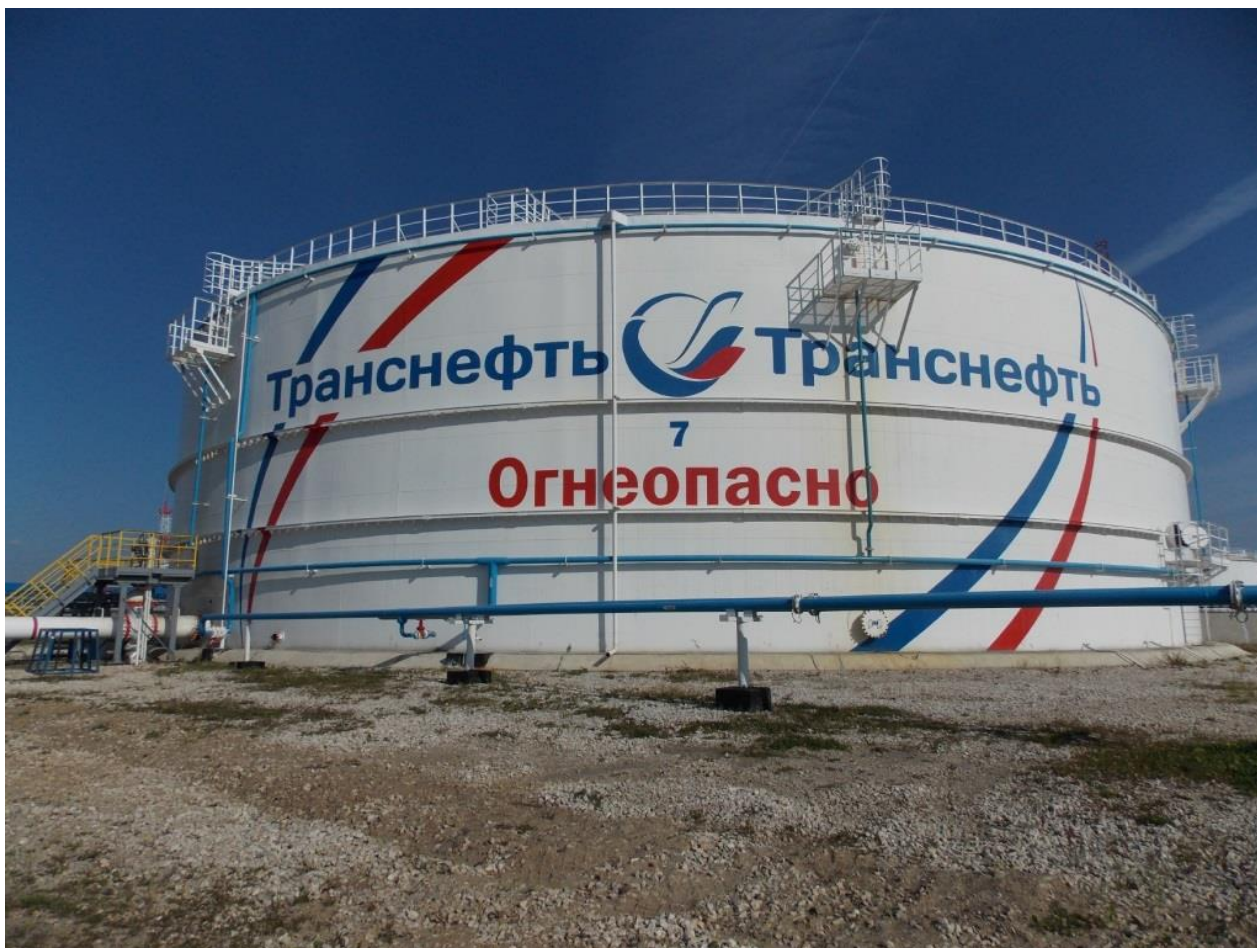
Рисунок 1 – Общий вид резервуара РВСП-20000
