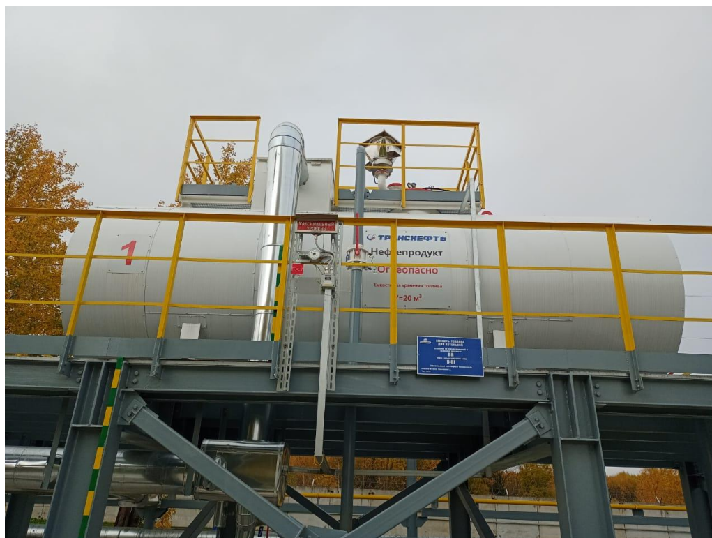
Рисунок 1 – Общий вид резервуара РГС-20
