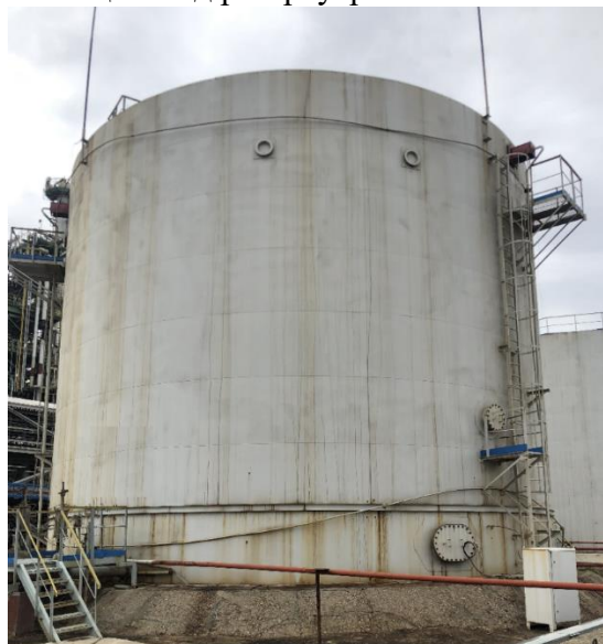
Рисунок 1 – Общий вид резервуара РВСП-1000 зав. № Е-308
