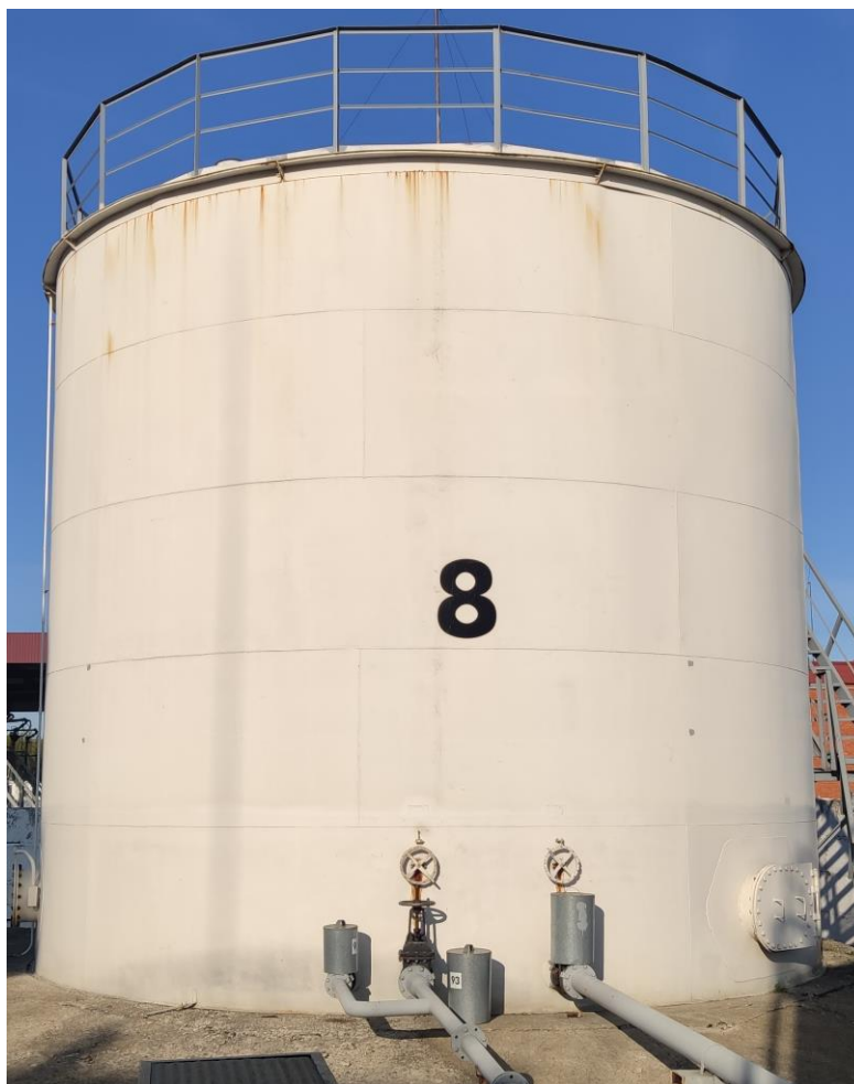
Рисунок 1 – Общий вид резервуара РВС-400
