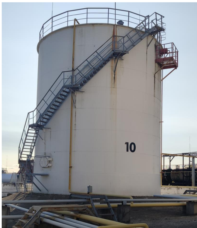
Рисунок 1 – Общий вид резервуаров РВСП-1000
