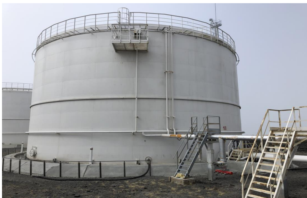
Рисунок 1 – Общий вид резервуаров РВС-200, РВС-1000, РВС-1400, РВС-2000, РВС-3000, РВС-5000
