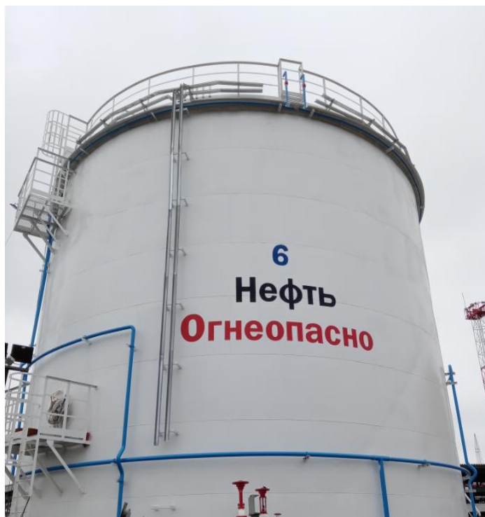
Рисунок 1 – Фотография общего вида резервуара вертикального стального цилиндрического с понтоном РВСП-2000 заводской номер 6
