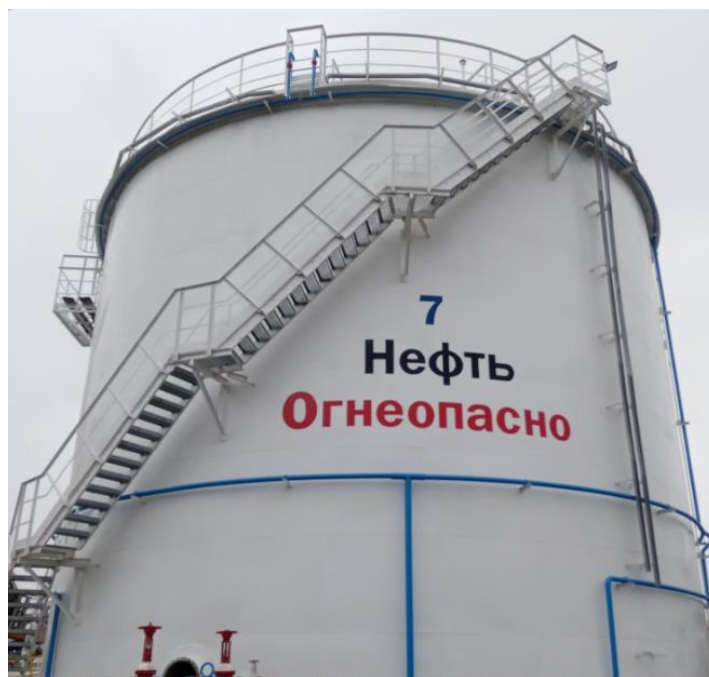
Рисунок 2 – Фотография общего вида резервуара вертикального стального цилиндрического с понтоном РВСП-2000 заводской номер 7
