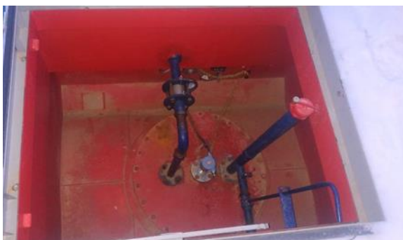
Рисунок 1 – Общий вид видимой части резервуара РГС-10 зав.№ 7/10-А
